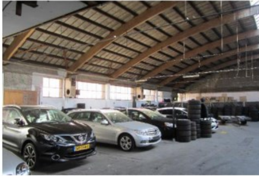
Tweede industriehal spanten zichtbaar binnen
